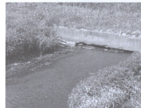
Fot. 7. Potok Czarniawka Zabrze – osady komunalne odłożone na brzegach.
