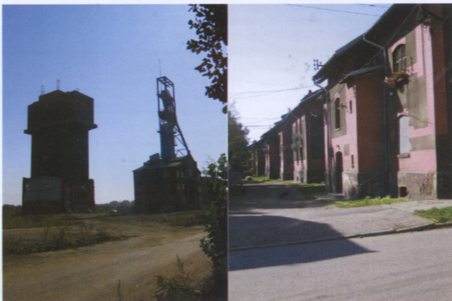
Rys.3. Charakterystyczne elementy zagospodarowania przestrzeni górnośląskiej – wieża wyciągowa szybu kopalnianego i zespół domów robotniczych (fot. Justyna Gorgoń, 2007 r.)
