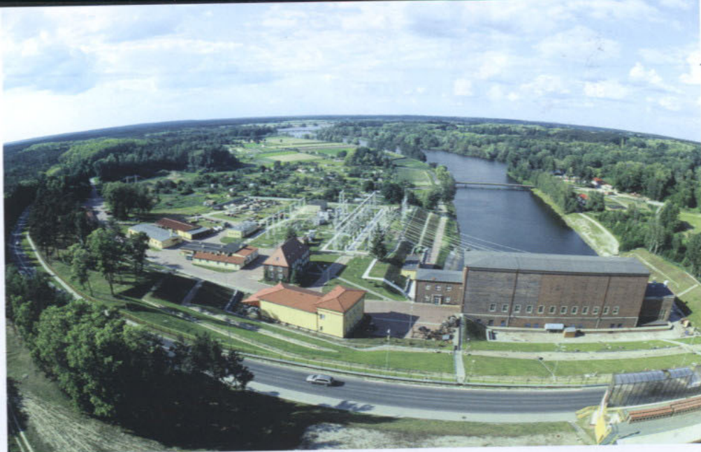
Elektrownia Wodna Dychów/ Dychów Water Power Plant
